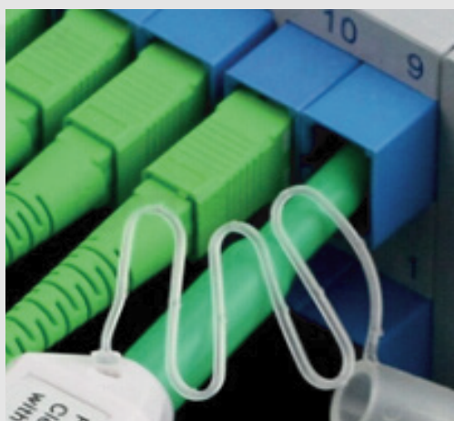
Limpeza da extremidade de fêrulas de conetores SC (também FC e ST)
