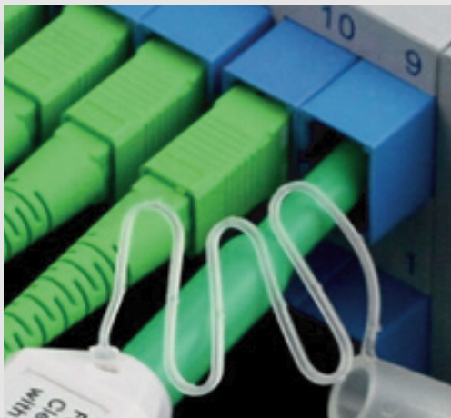
Limpieza de conectores SC ( también FC y ST)
